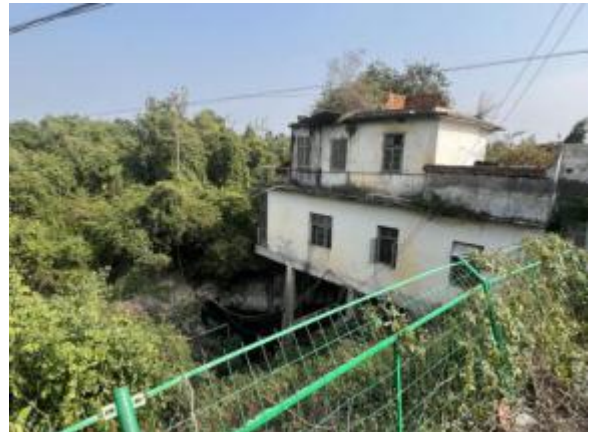
乔建镇博浪村小龙潭水源地取水口
