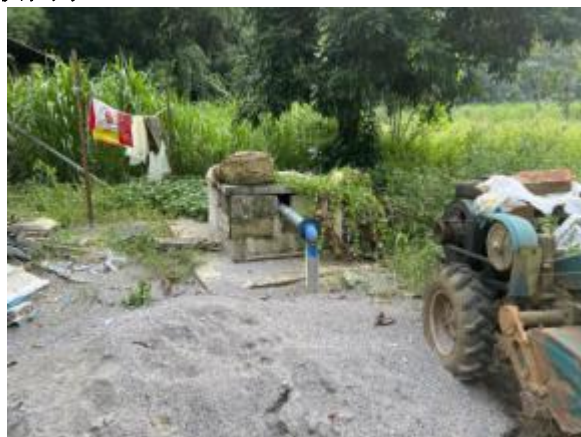
隆安县乔建镇龙弟村地下水型水源地取水口
