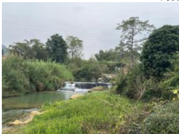
乔建镇慕垦水源地取水口
